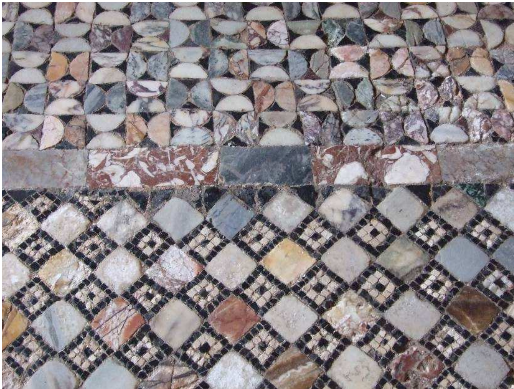
Torcello, kl. kostel, mosaiková dlažba poč. 13. stol.
