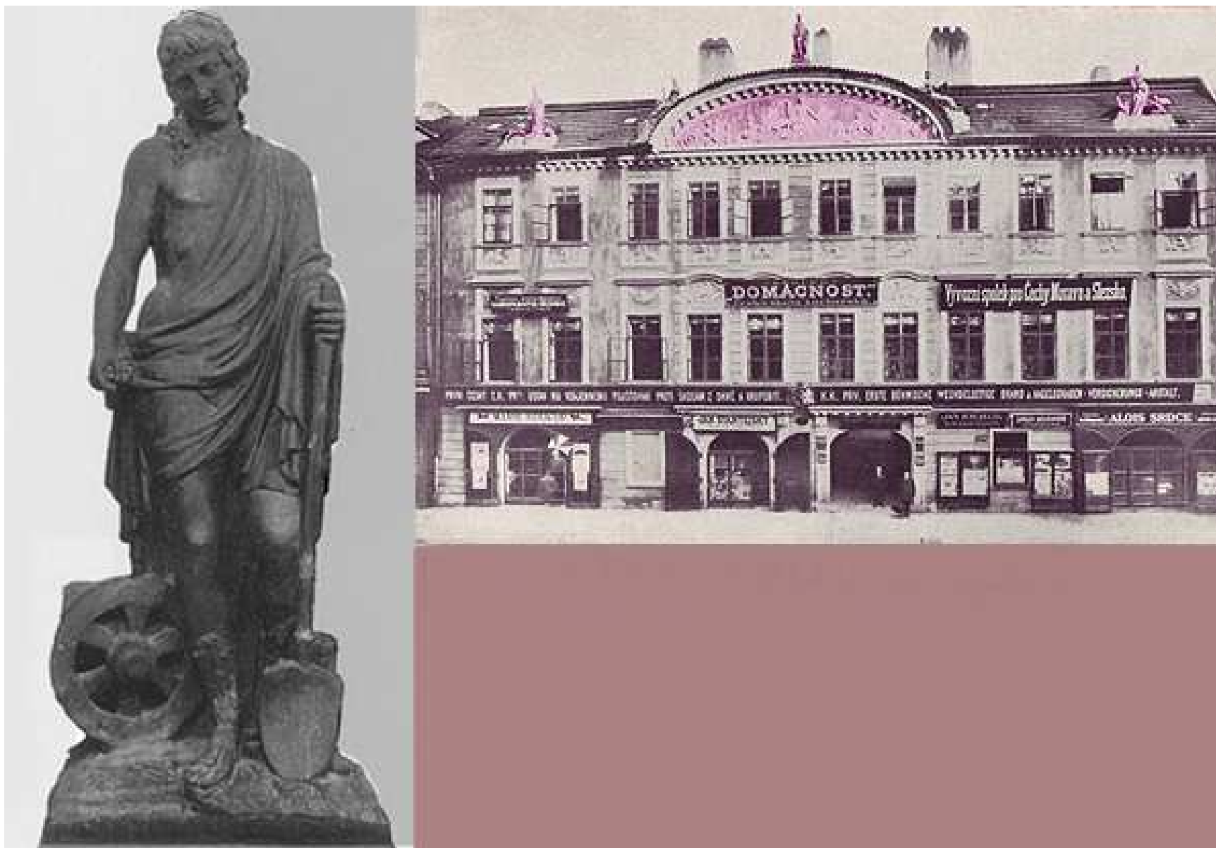
Prachnerové, Personifikace Průmyslu a další výzdoba fasády domu První české pojišťovny, 1800-1820
