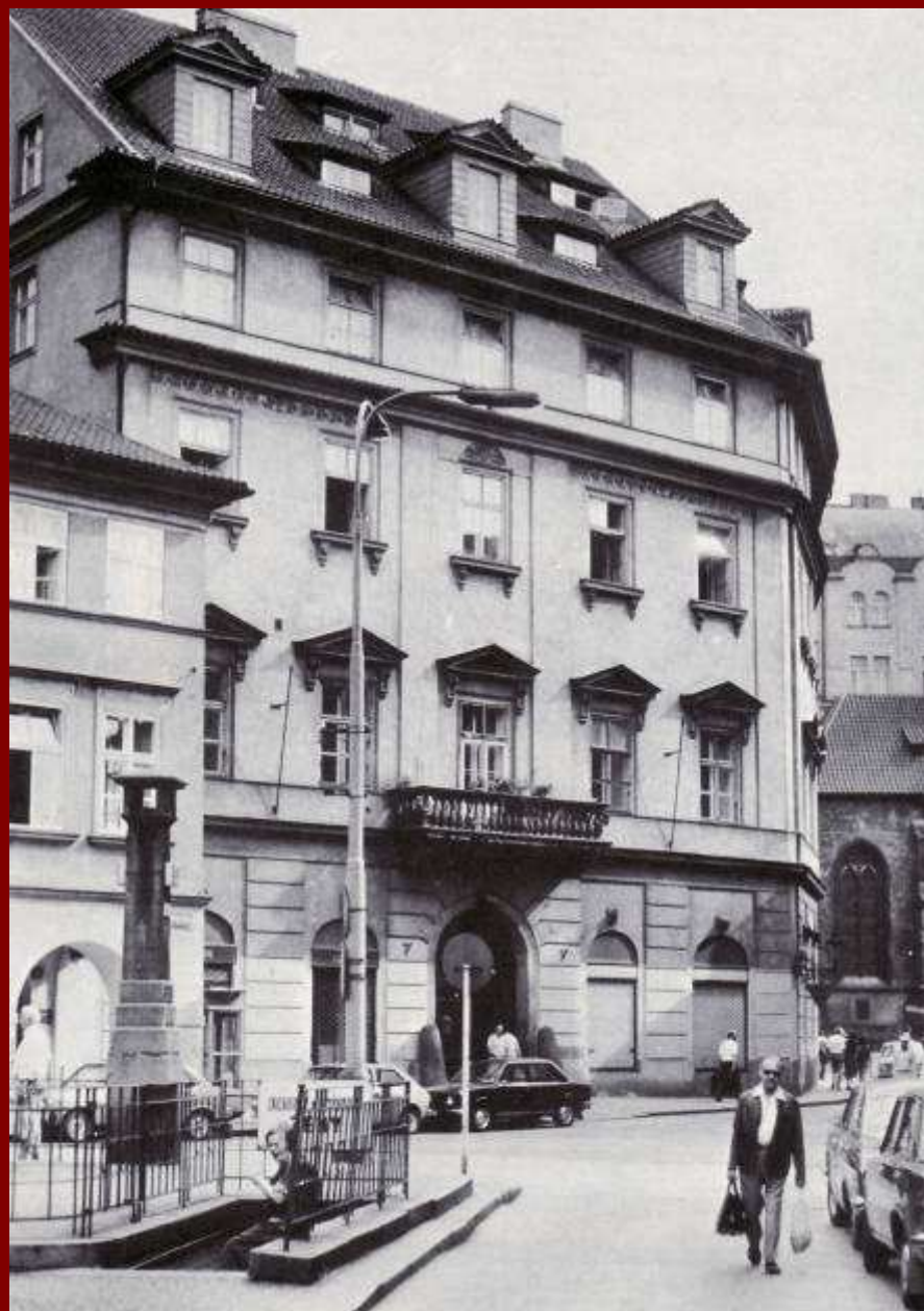
Praha – Staré Město, Heinrich Hausknecht, nájemní dům Platýz, 1813-47
