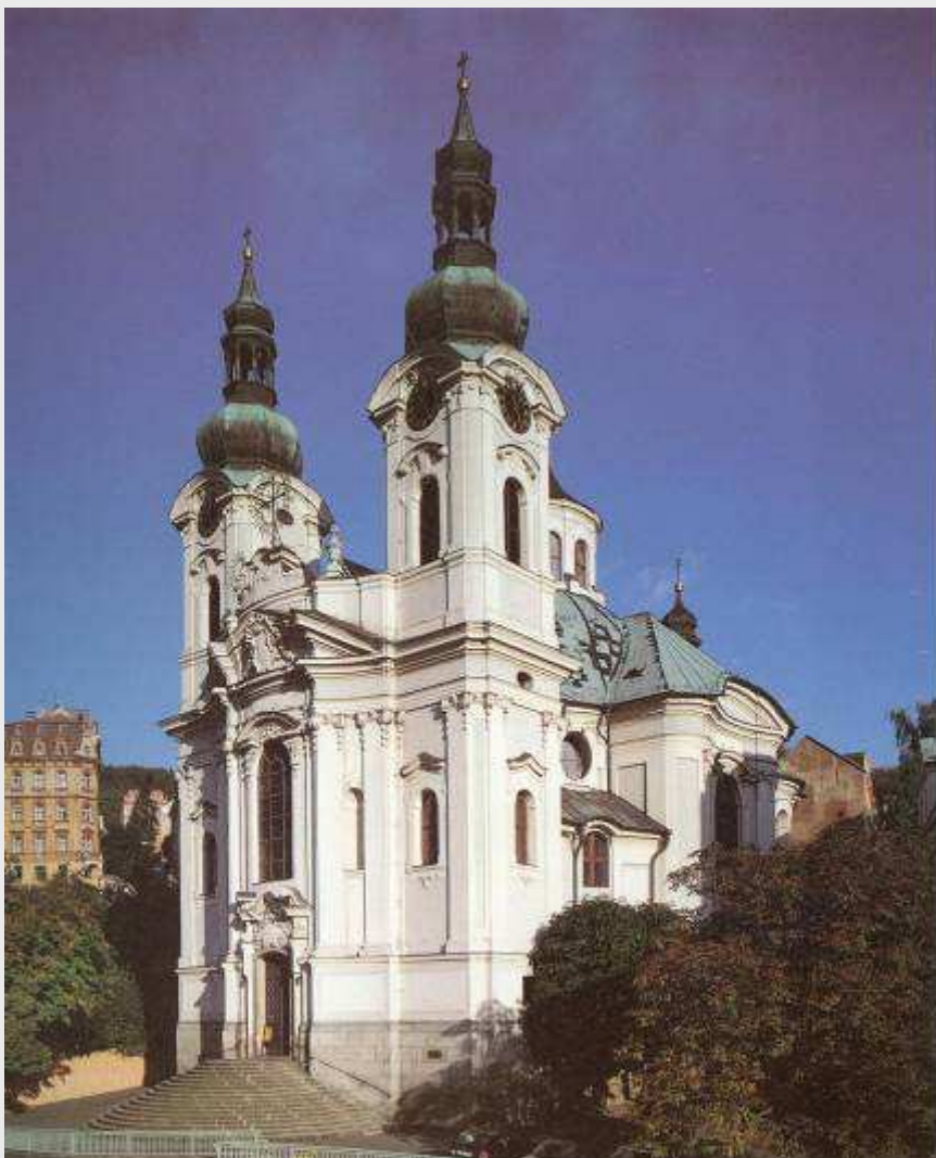
Karlovy Vary, kostel sv. Máří Magdalény, exteriér, celkový pohled od jihovýchodu Karlovy Vary, Kirche der Hl. Maria Magdalena, Exterieur, Gesamtansicht von Südosten
