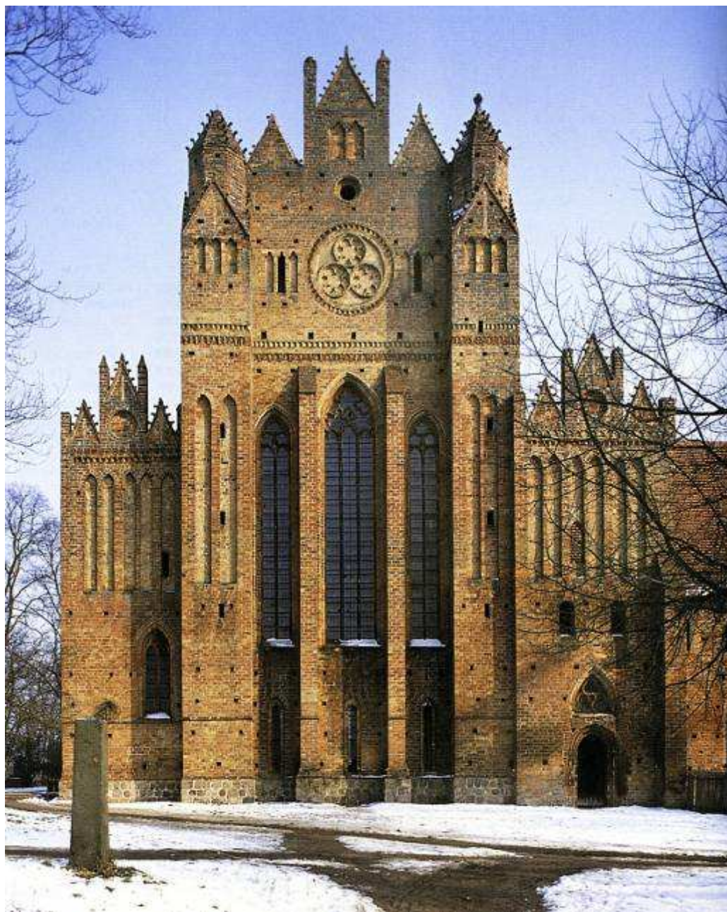
CHORIN V BRANIBORSKÉ MARCE, býv. cisterciácký klášter, západní průčelí kostela, založení kláštera 1273, stavba kostela 1273-1309
